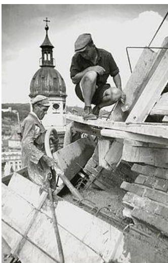
Betonierung einer Rippe der Kuppel, August/September 1948 Foto: Archiv der Erzdiözese Salzburg/Siegfried Moyses
